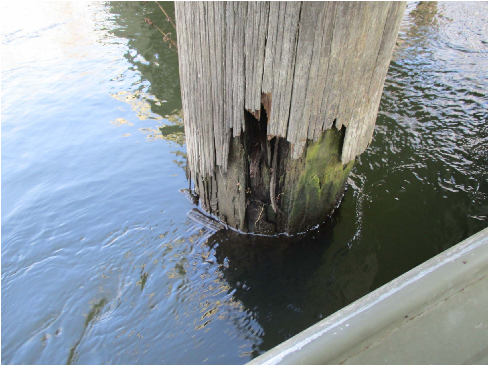
Pier 4S pile 1W
