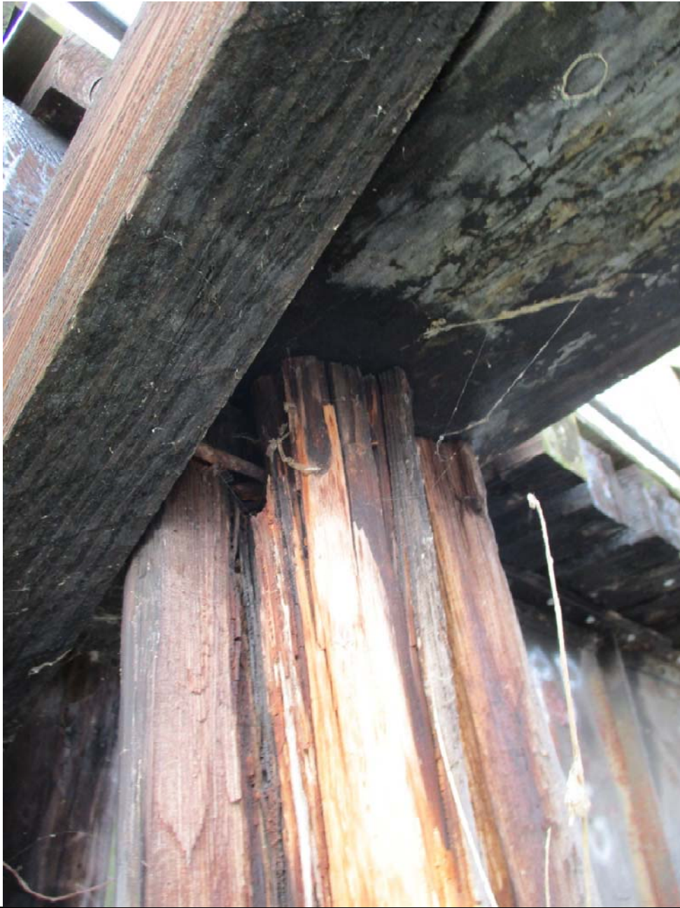
Pier 7S top of pile 1E
